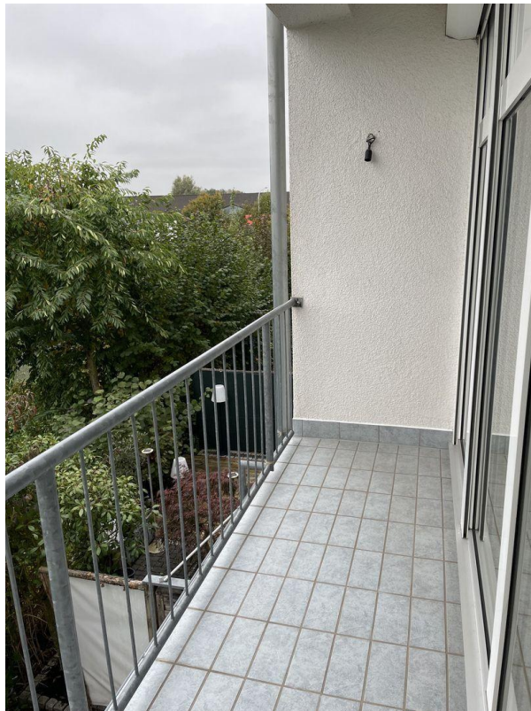
OG1 - Kinderzimmer Loggia
