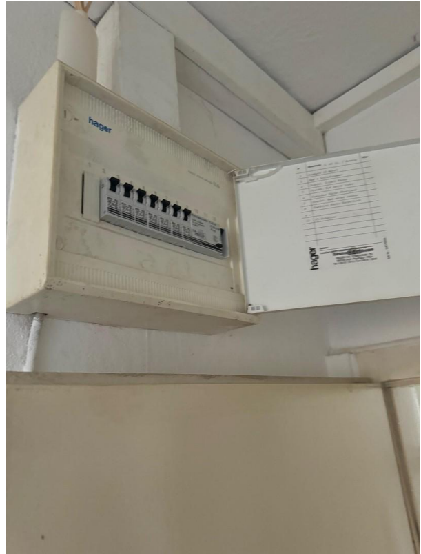
SICHERUNGSKASTEN BEISPIEL WOHN
