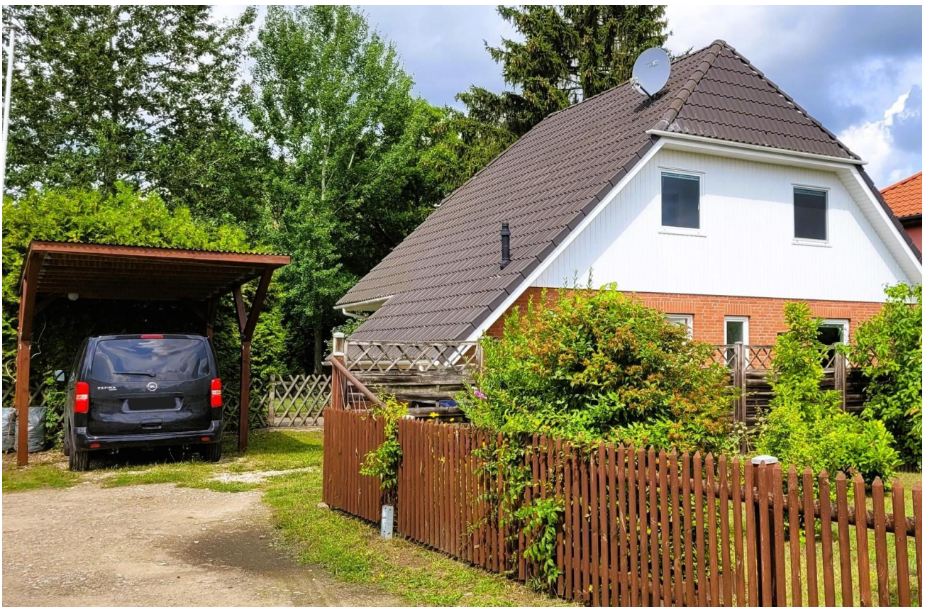
Blick von der Einfahrt
