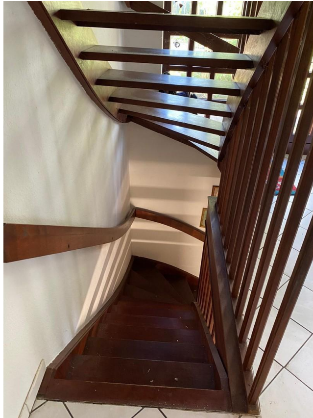
Treppe zum Keller
