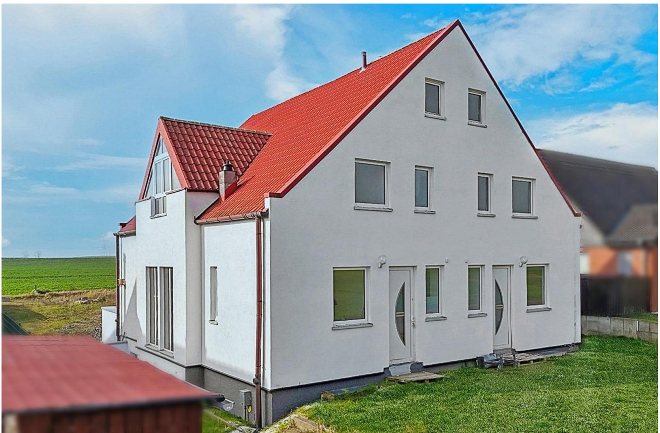
Hausansicht linke Haushälfte
