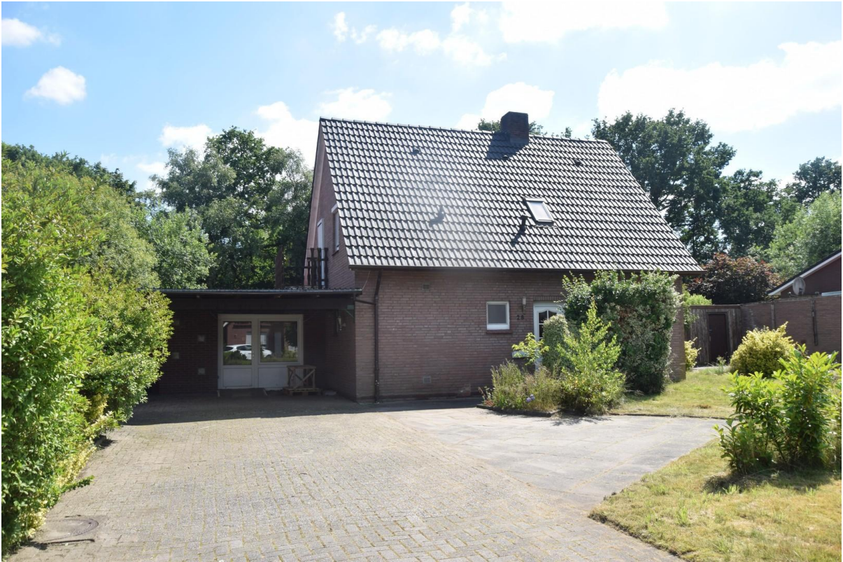
Einfahrt mit Carport/Stellpl.
