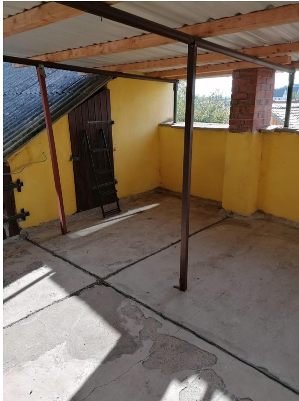
Balkon (Übergang Stall)
