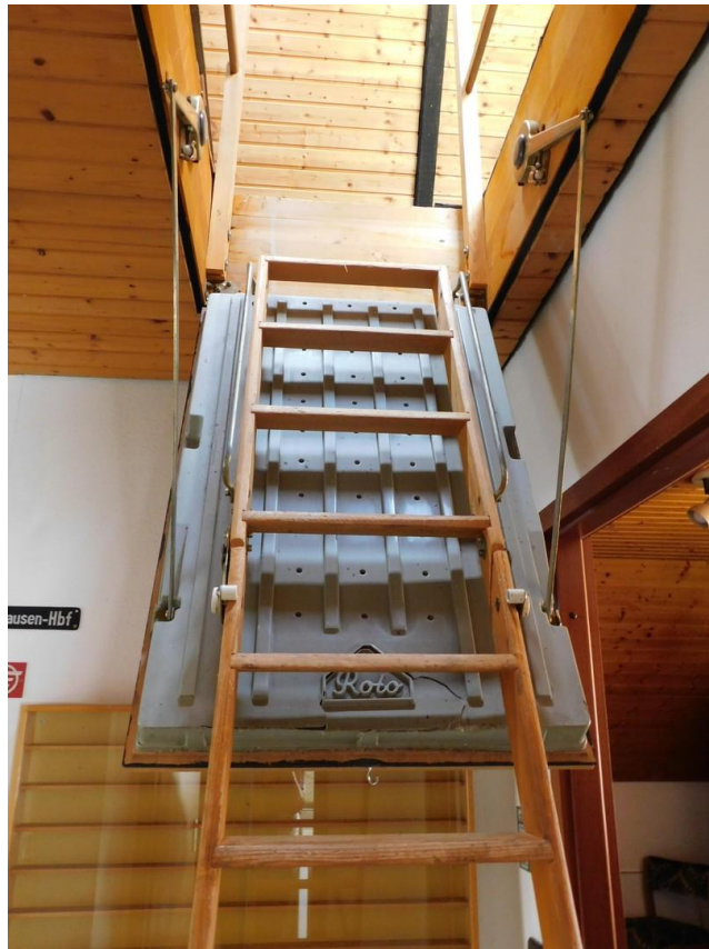
Treppe zum Dachboden
