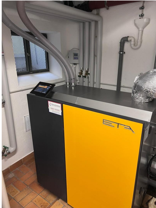
Neue Holzpellet-Heizung
