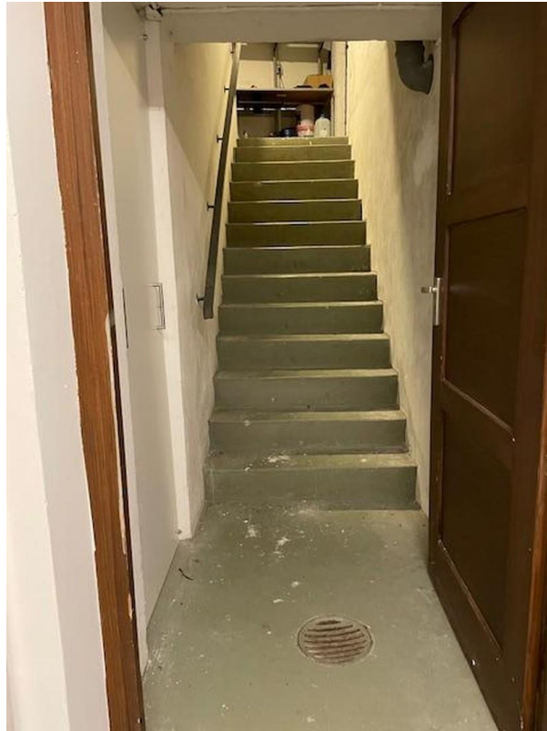
Zugang zur Garage vom Keller
