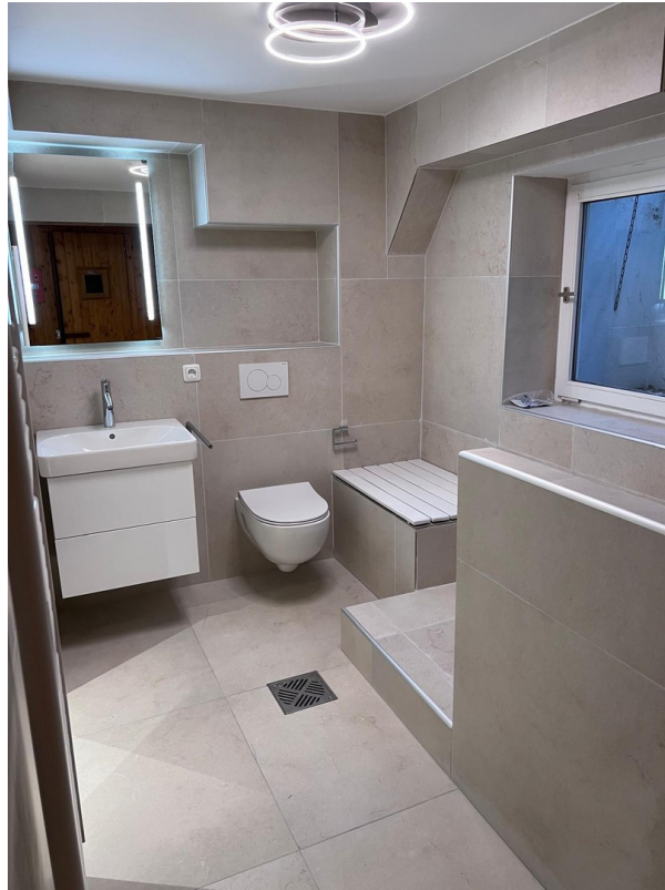
Sanitärbereich bei Sauna
