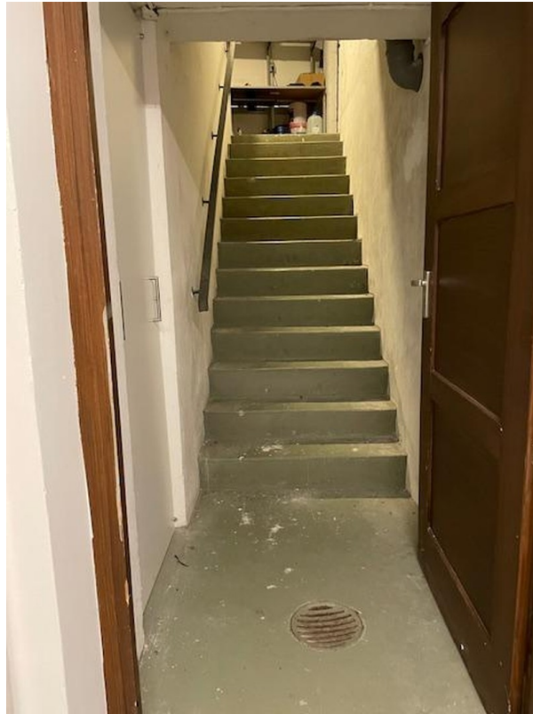
Zugang zur Garage vom Keller
