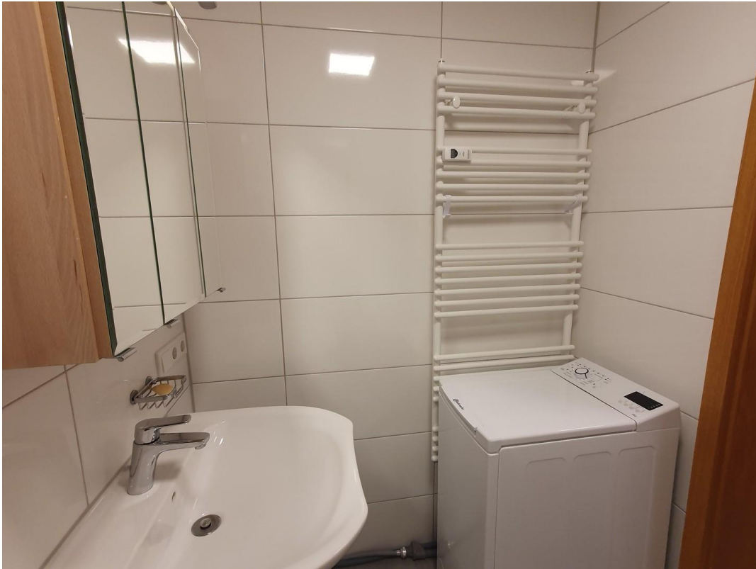
Bad, mit Handtuchheizung
