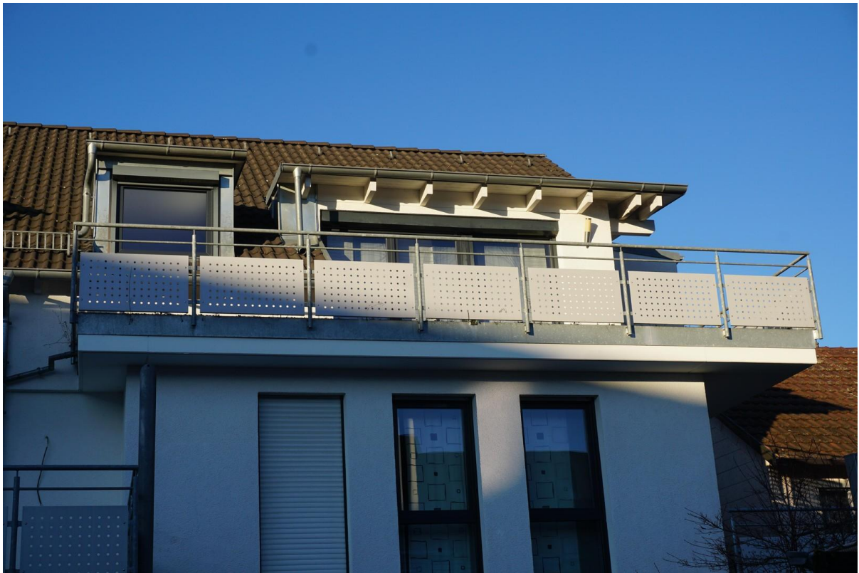
Balkon von außen
