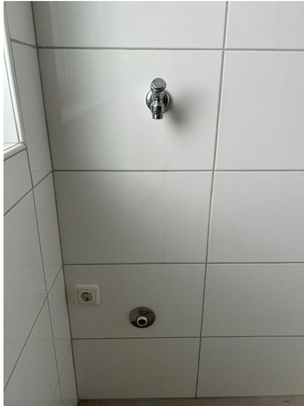
Waschmaschinenanschluss Bad
