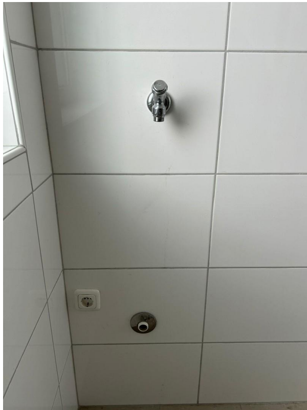
Waschmaschinenanschluss Bad
