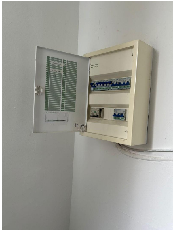
Stromverteilerkasten
