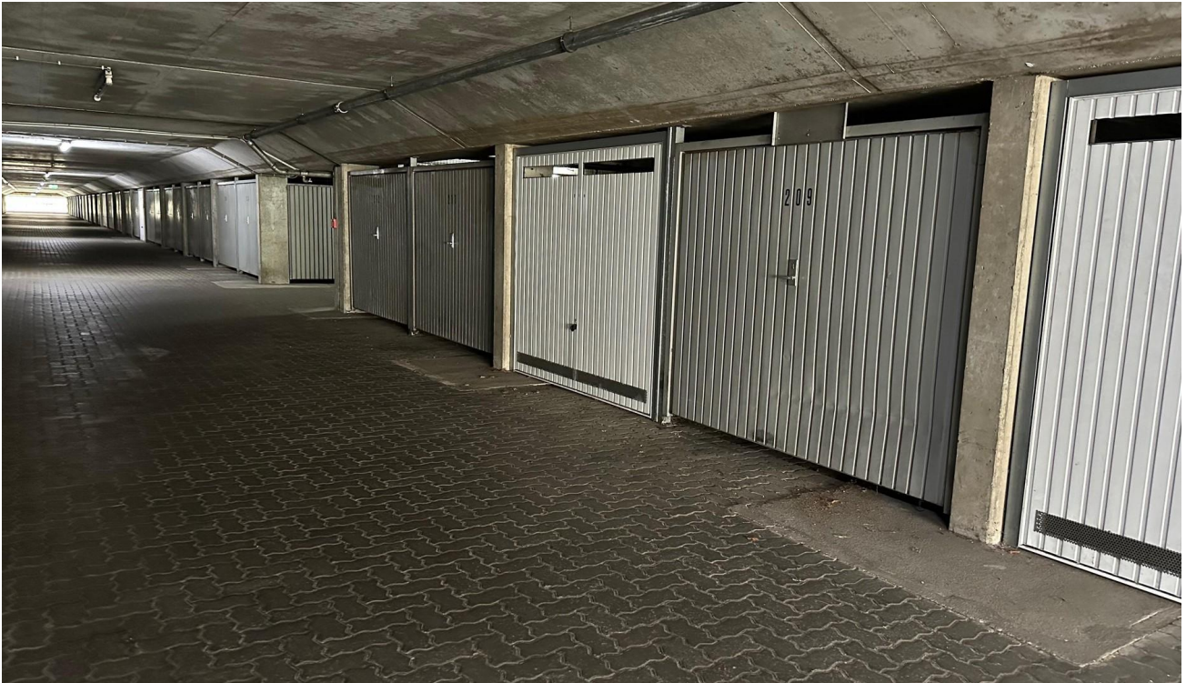
Einzelbox in der Tiefgarage
