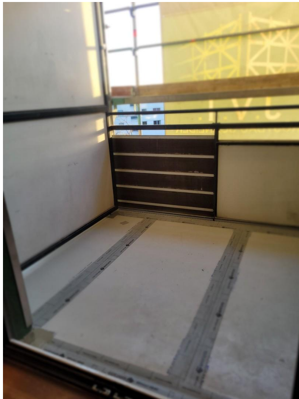
Balkon, der gerade saniert wird
