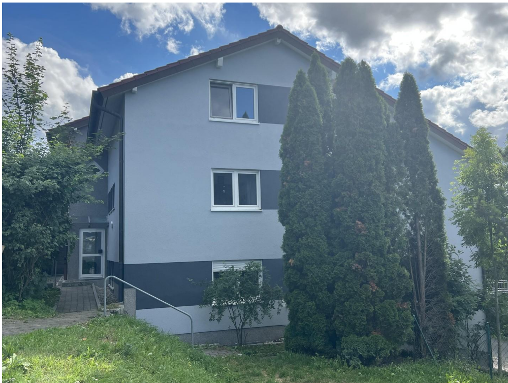
Haupteingang Weg zu den Stellp
