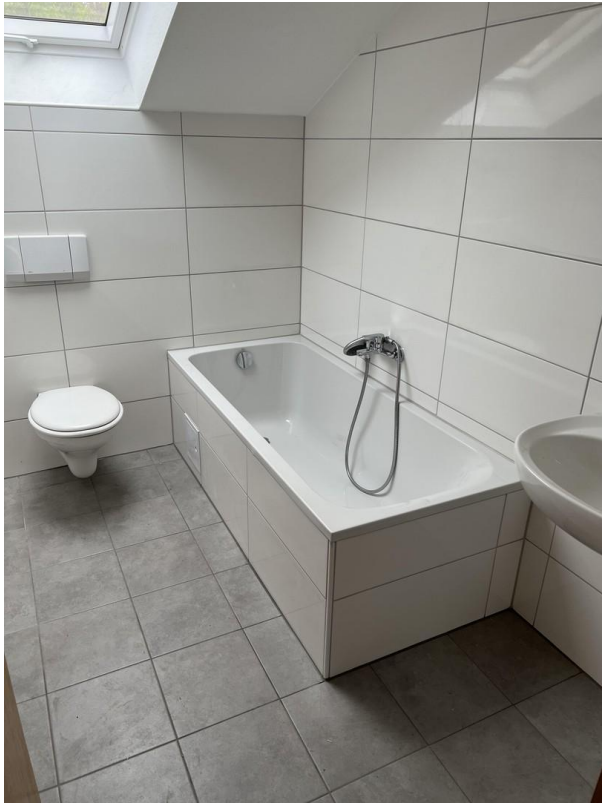
DG Wannenbad saniert
