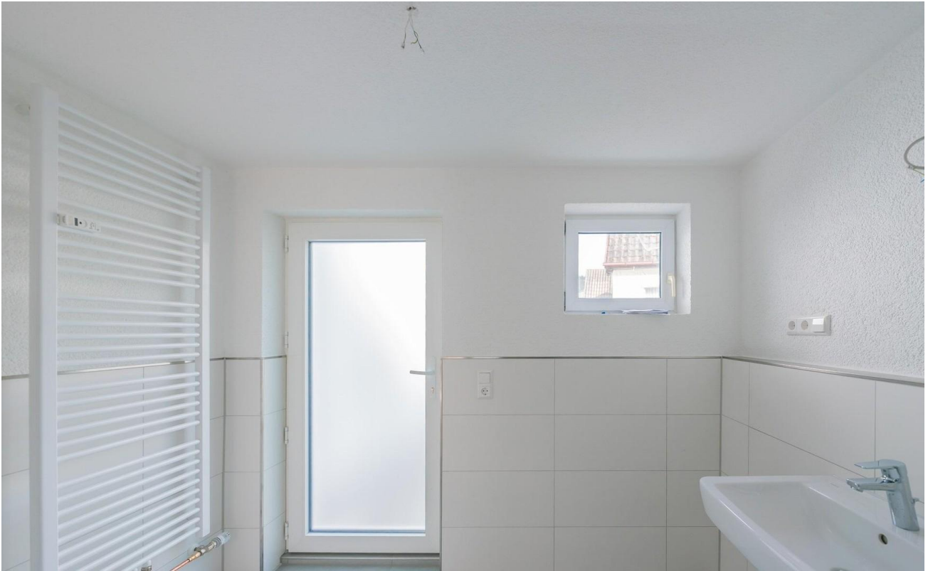
Bild 3 ELW (neu saniert 2024)
