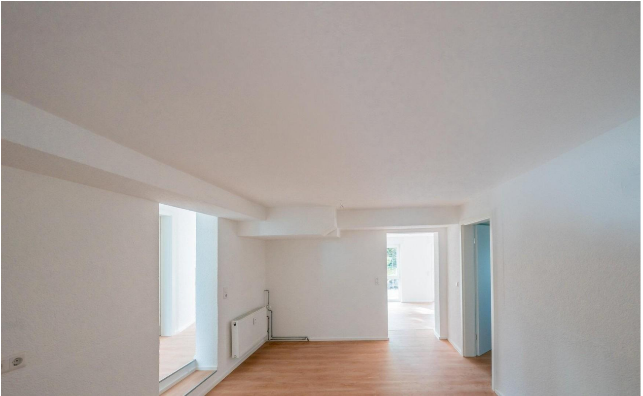
Bild 11 ELW (neu saniert 2024)
