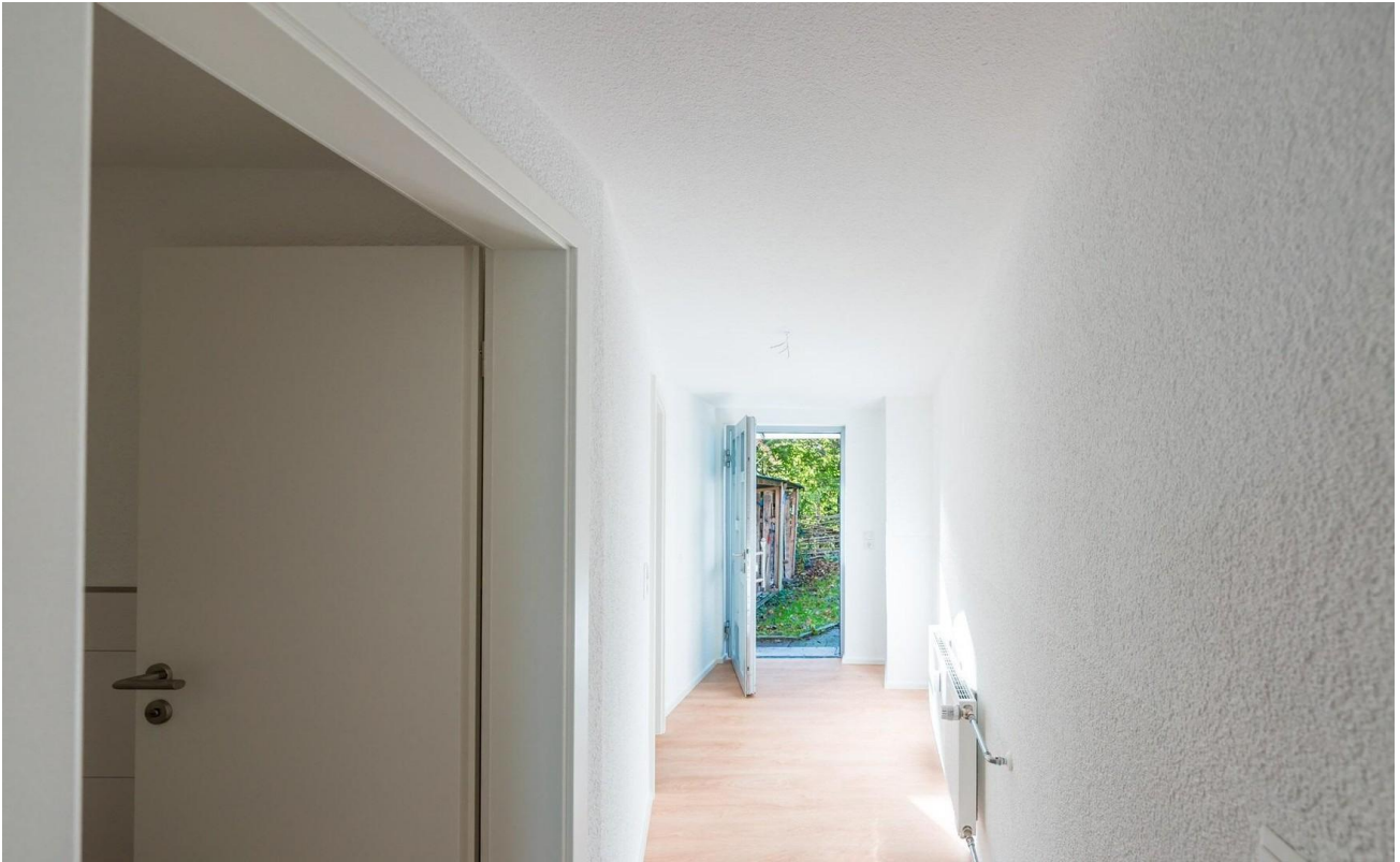
Bild 5 ELW (neu saniert 2024)
