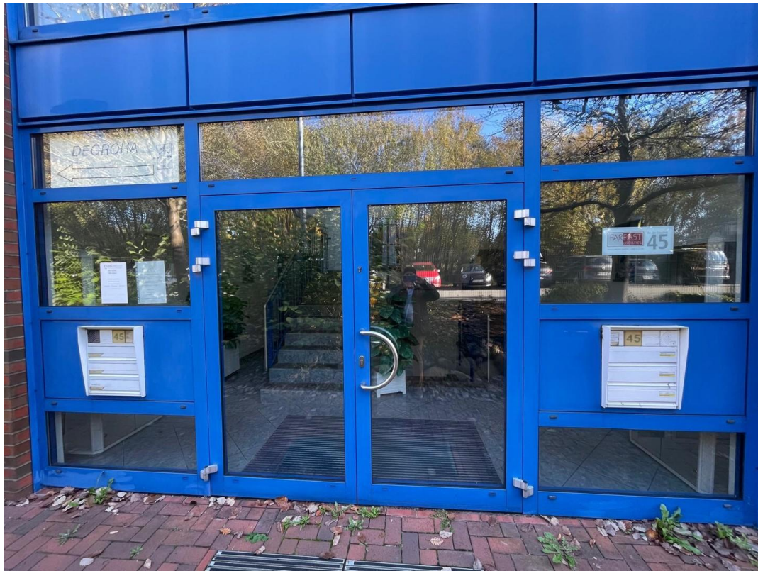
Eingang zum Treppenhaus
