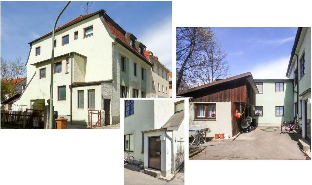
Objekt Altbestand 418m 2
