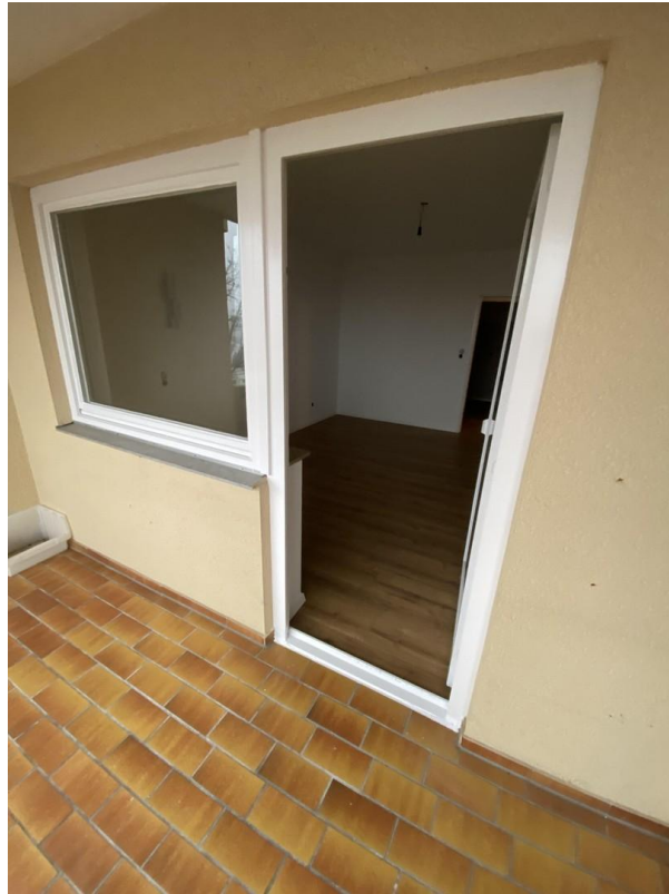
Balkontür WG Zimmer 1
