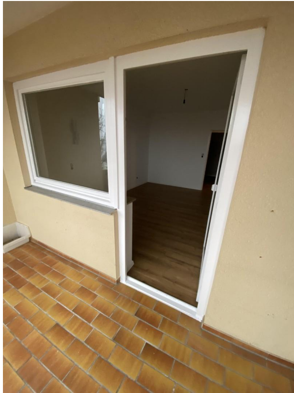
Balkontür WG Zimmer 1
