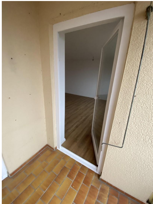
Balkontür WG Zimmer 2
