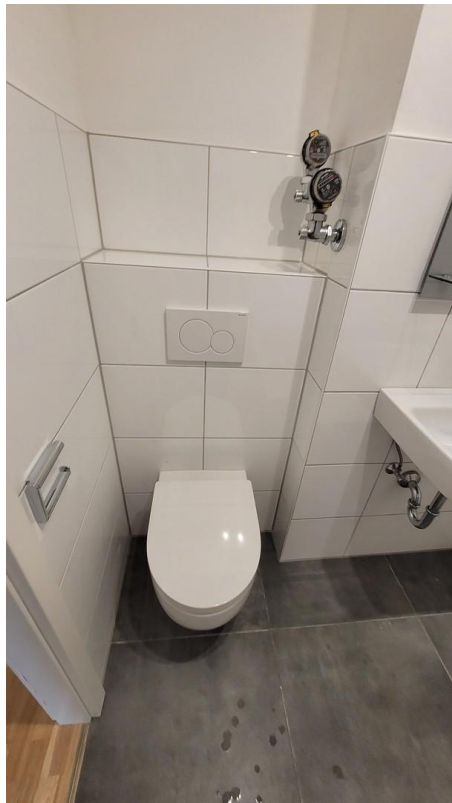
Waschmaschinenanschluß
