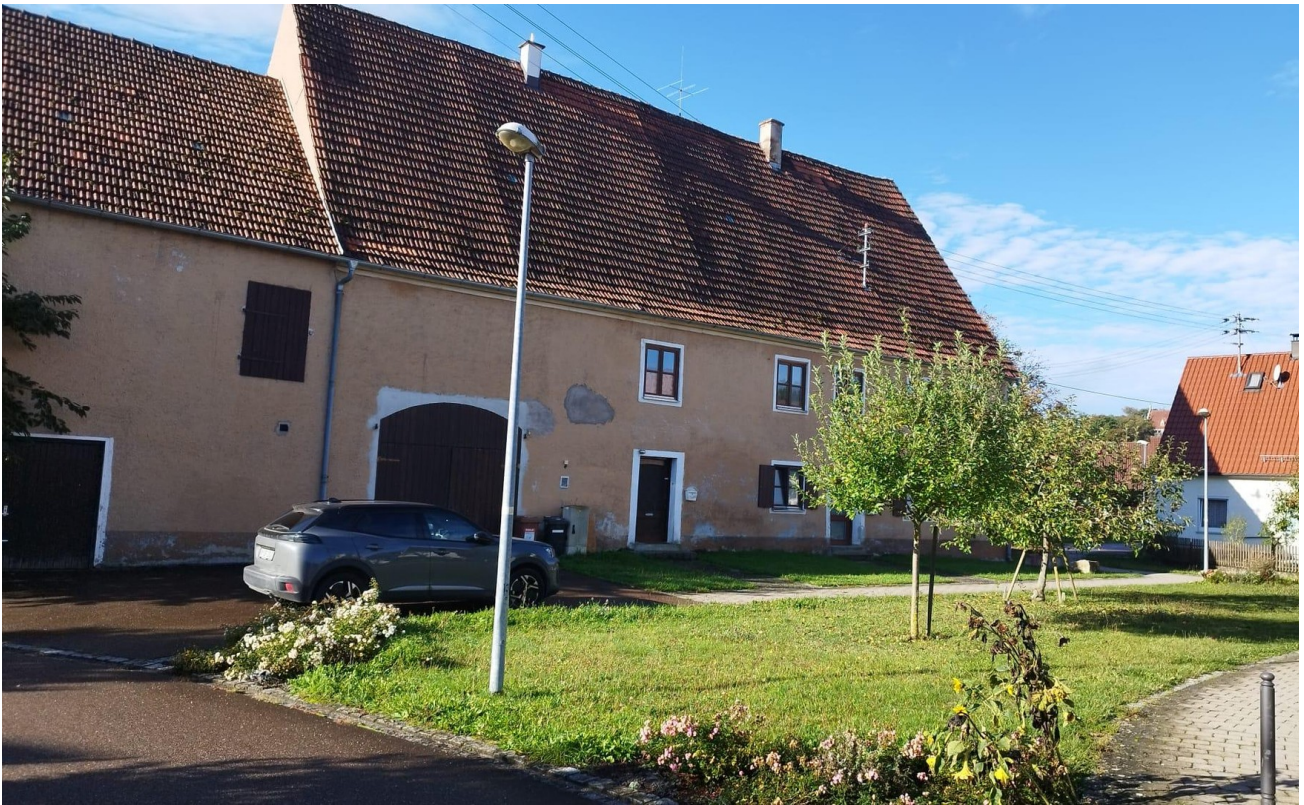
Nord mit Anbau
