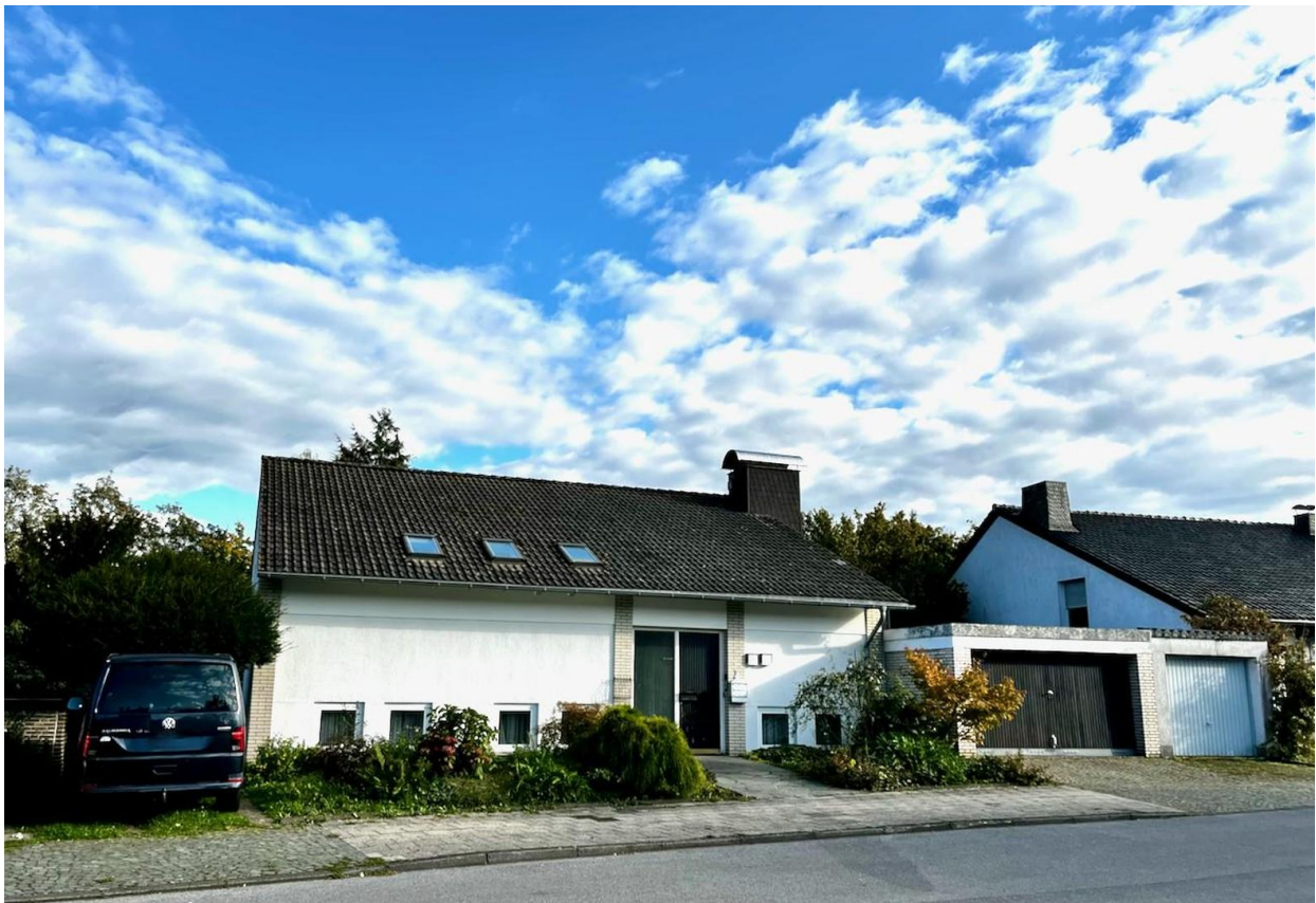
links Stellplatz rechts Garage
