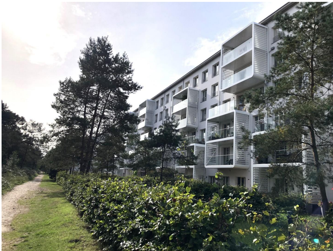
Meerseite Ansicht Gebäude
