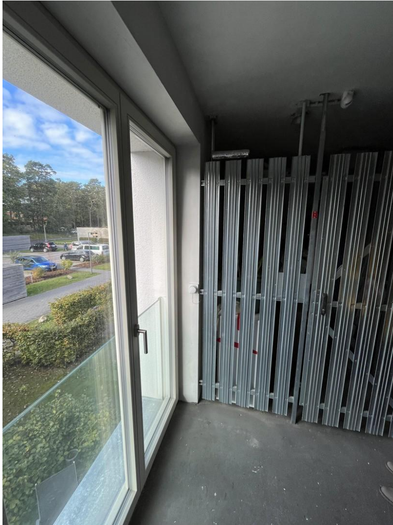
Abstellraum (im 1. OG)
