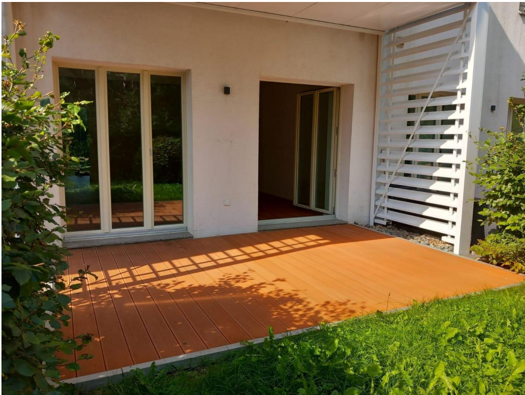
Terrasse Meerseite Ansicht 2
