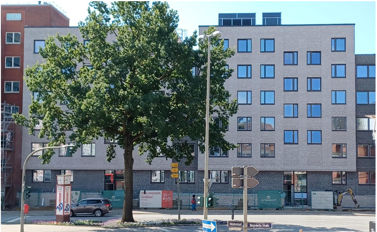
Außenansicht Bergedorfer Straße
