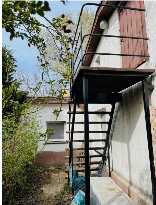
Aufgang zum Dachboden
