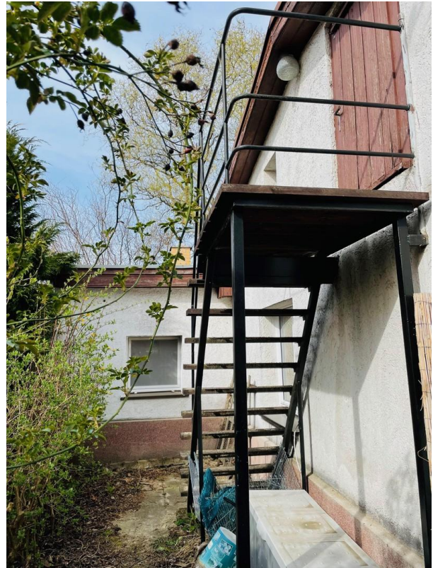
Aufgang zum Dachboden
