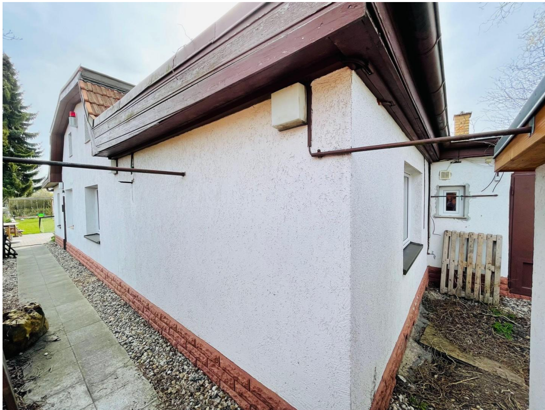
Weg zum Heizungsraum
