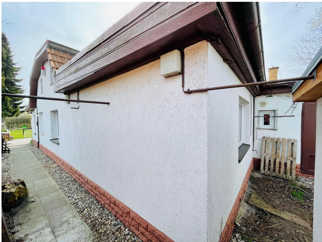
Weg zum Heizungsraum
