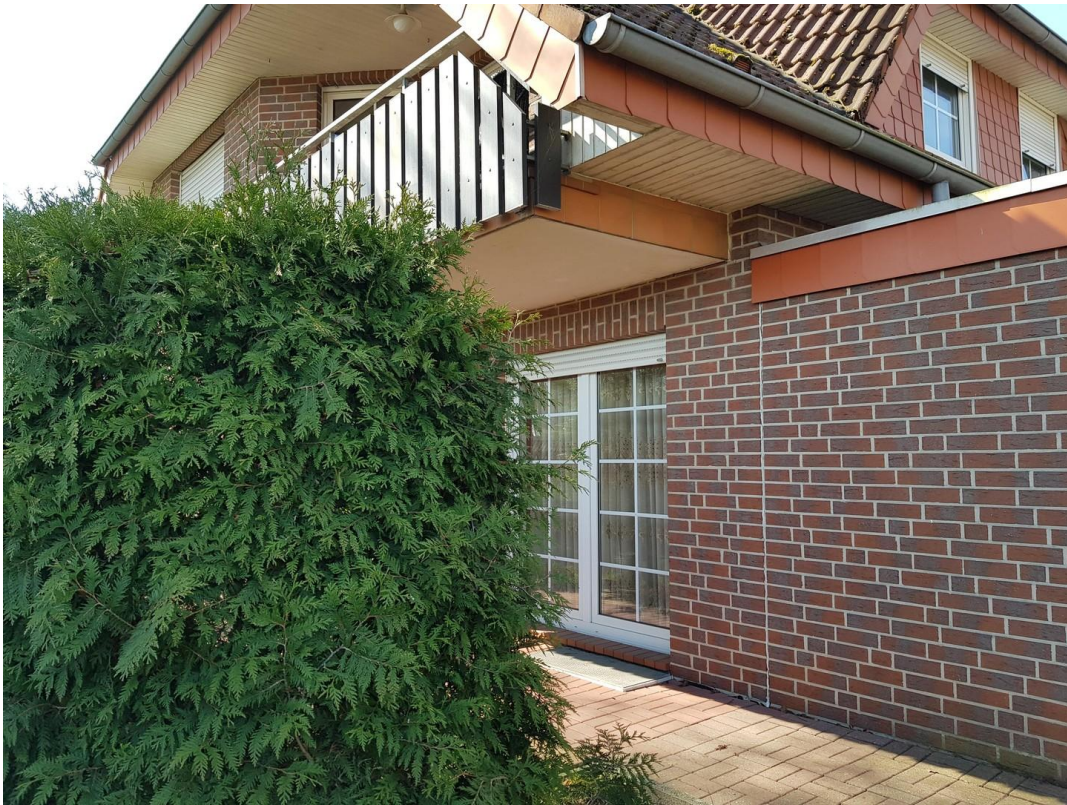
gut sichtbare Loggia
