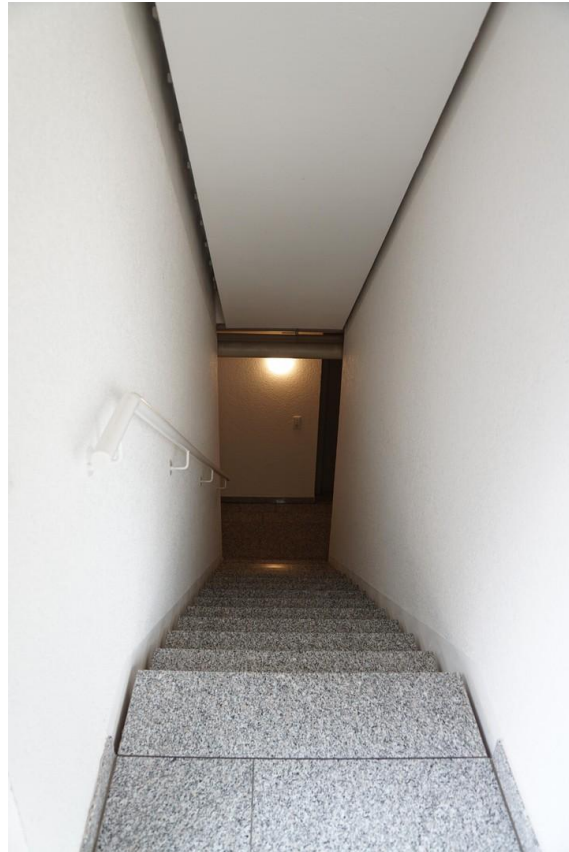
Treppenabgang in UG1 und UG2
