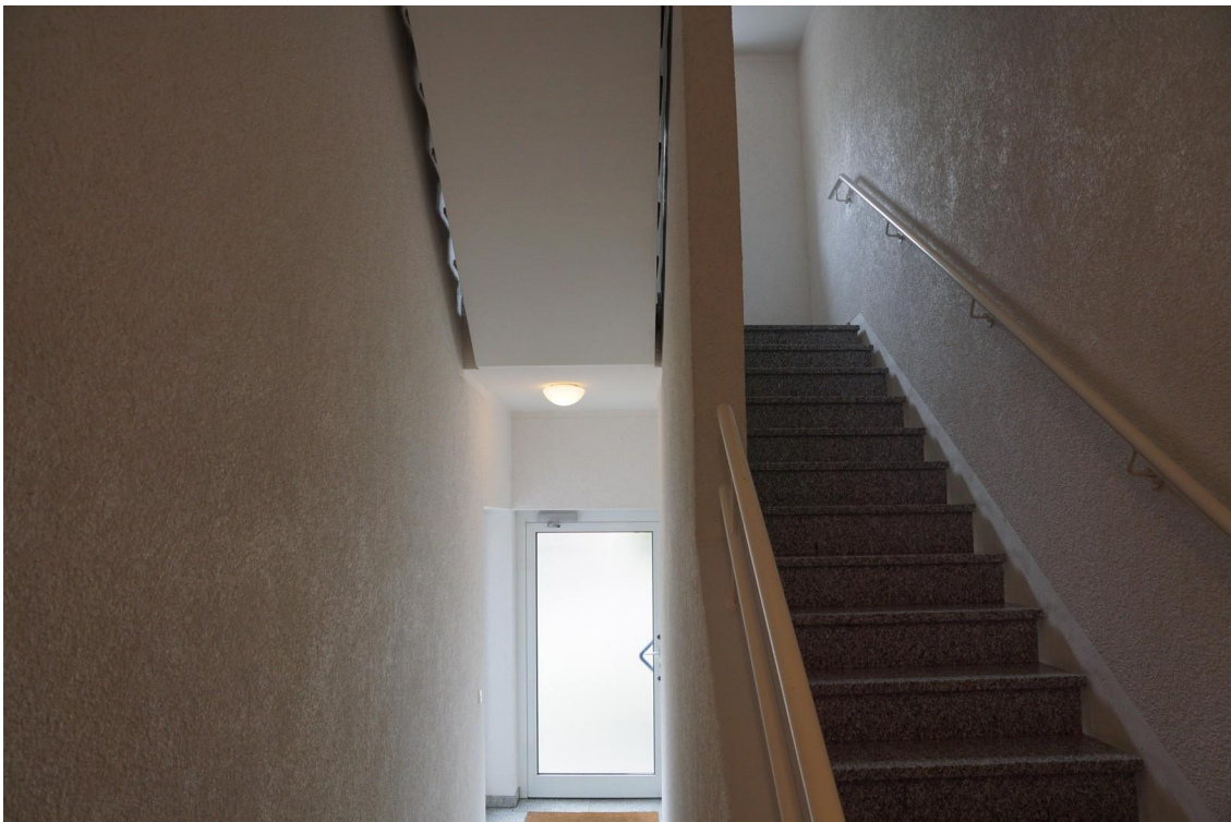
Treppenhaus von Aufzug in EG
