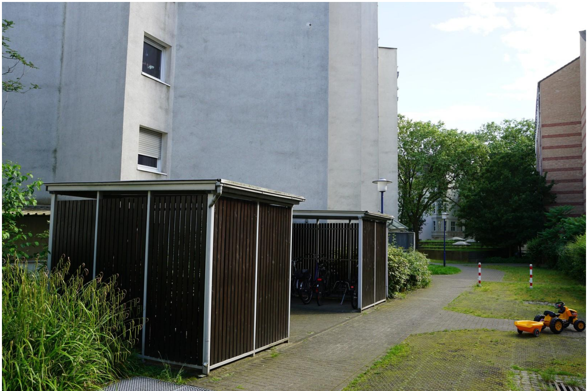
Feuerwehzufahrt zum Innenhof
