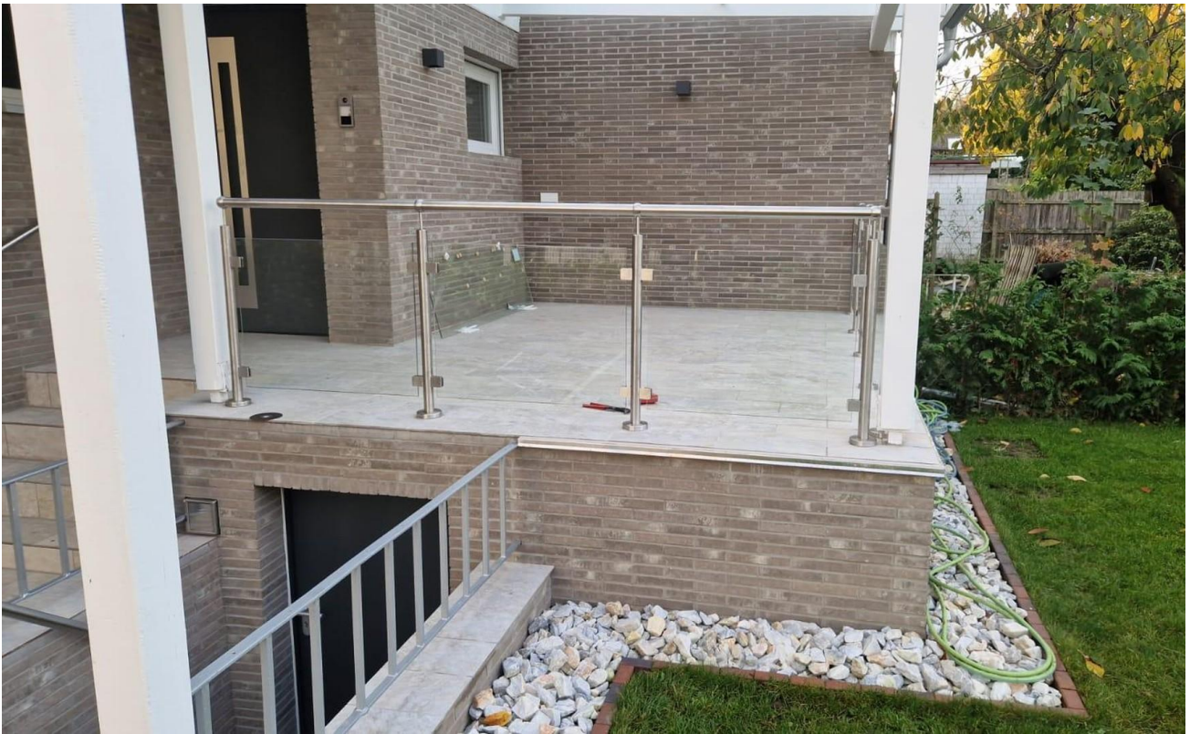
Terrasse mit Brüstung 1
