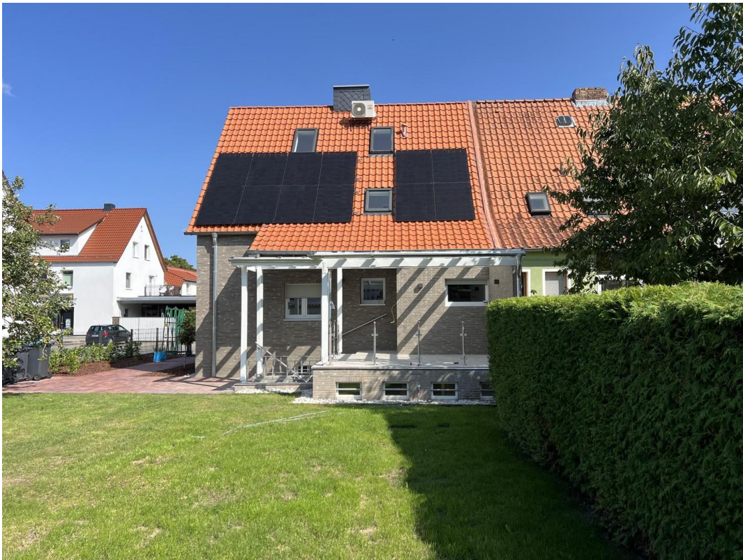
PV Anlage & Garten Rückseite
