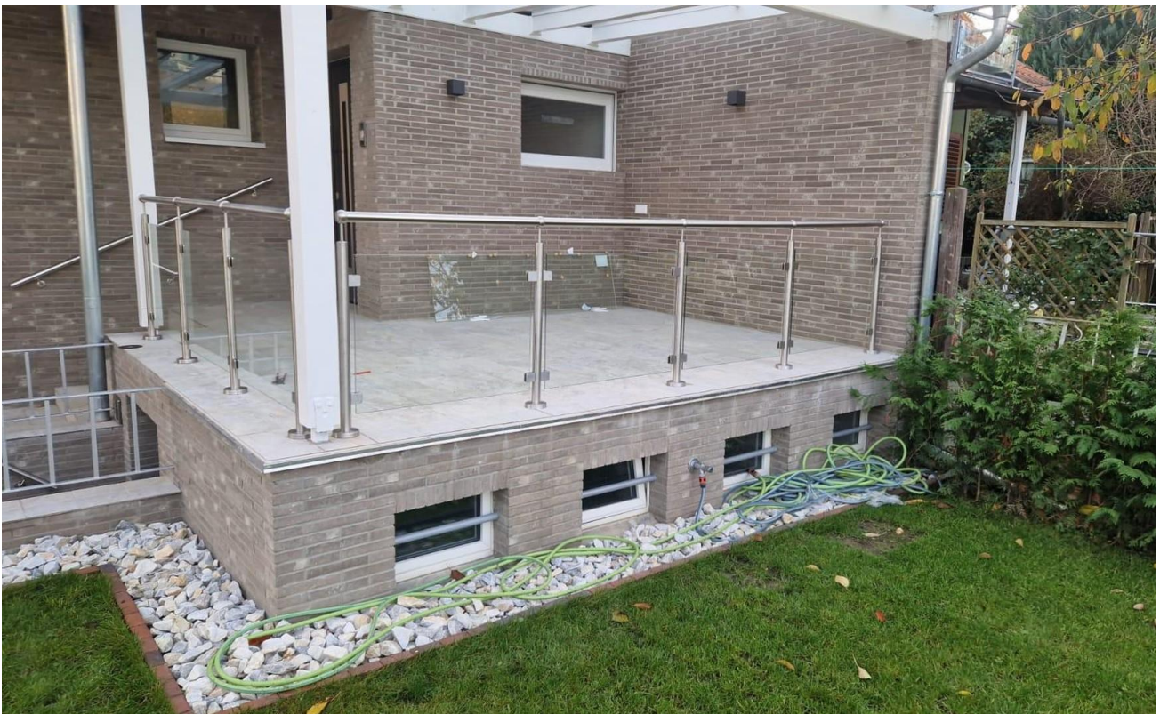
Terrasse mit Brüstung 2
