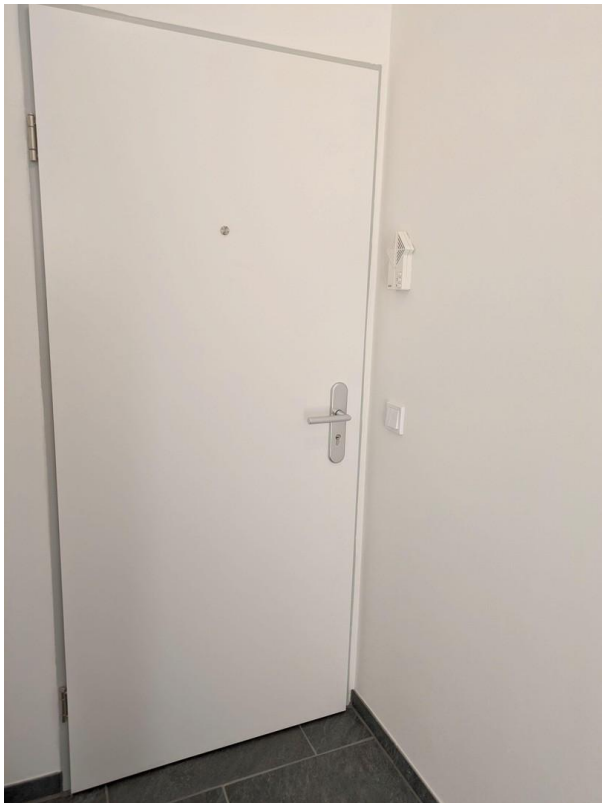
Eingangstür mit Sprechanlage
