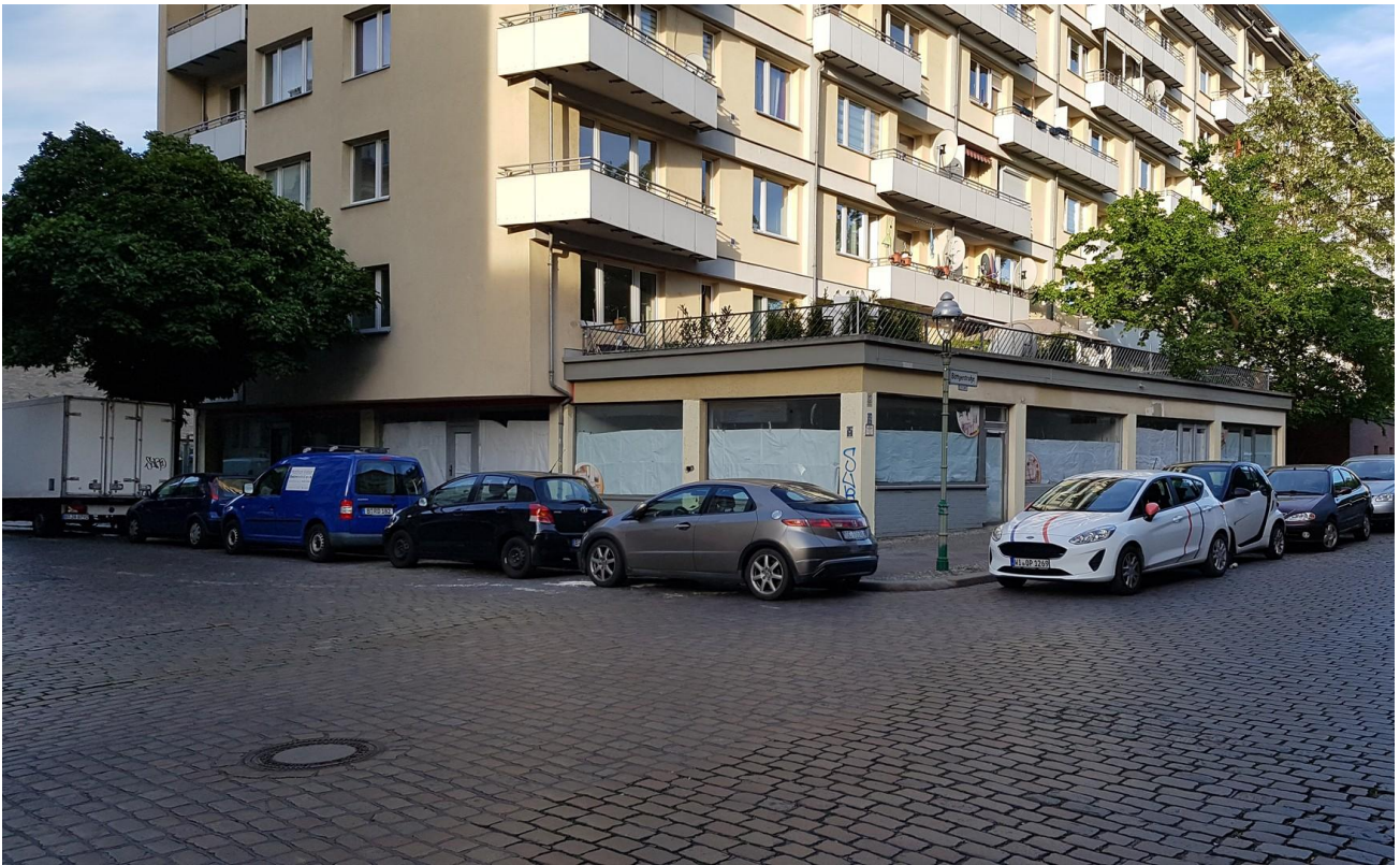
Hausansicht EG - von Bö-Str.
