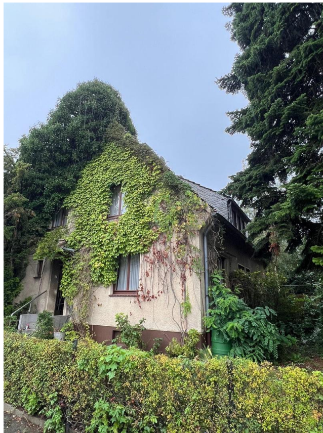
Außenansicht von der Straße
