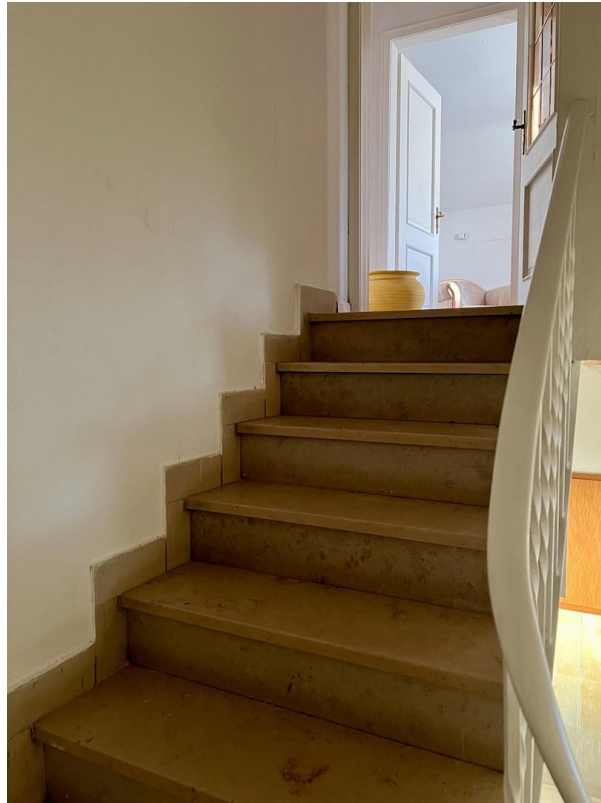
Treppe zum OG
