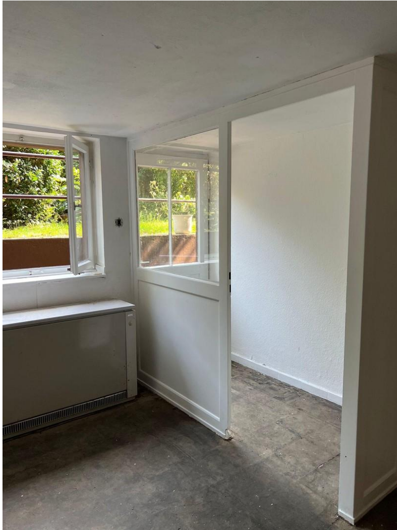
Souterrain mit Gartenzugang
