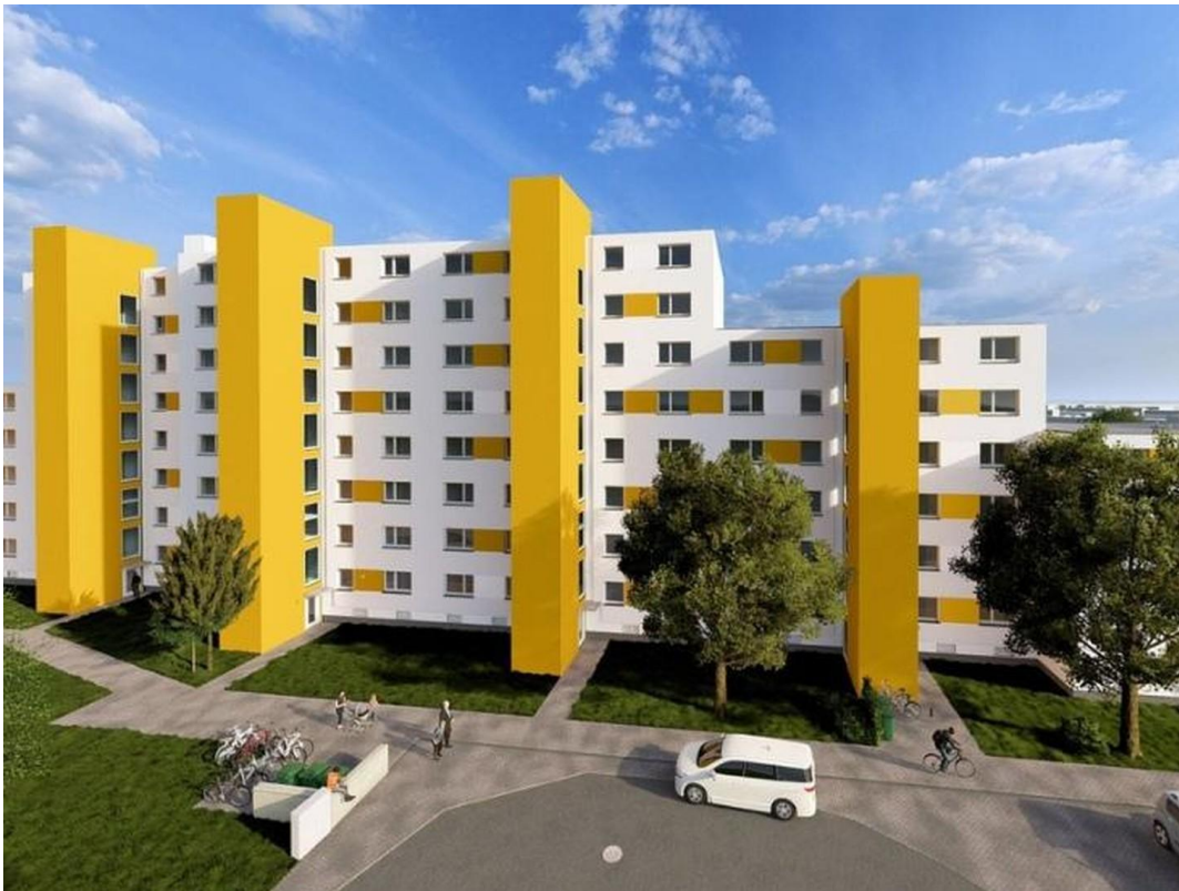
Gebäude nach Modernisierung
