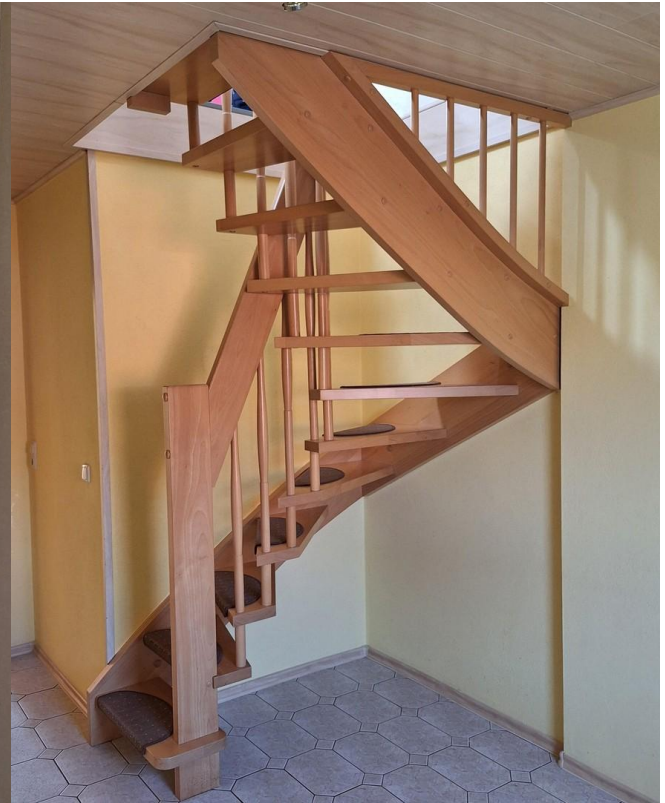
Treppe zum DG Haus 2
