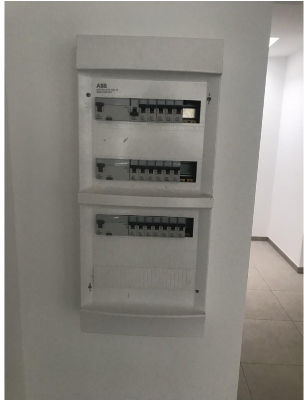
Neuer Sicherungskasten
