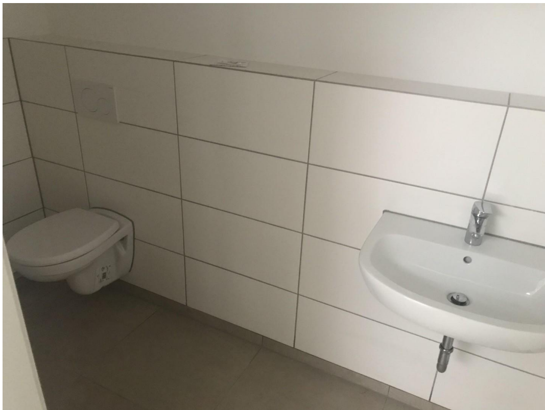
Separates WC und Waschbecken
