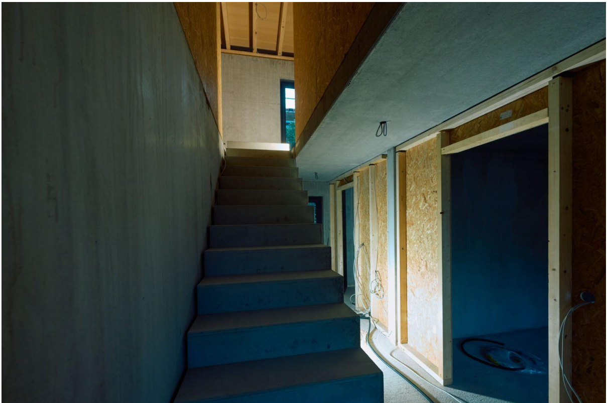
Treppe ins DG
