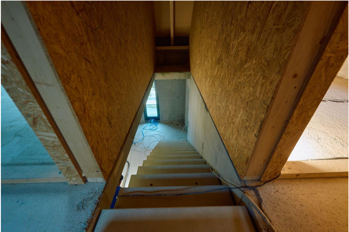
Treppe DG zum OG
