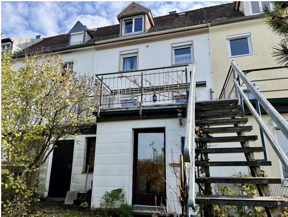
Rückseite Aufgang Terrasse
