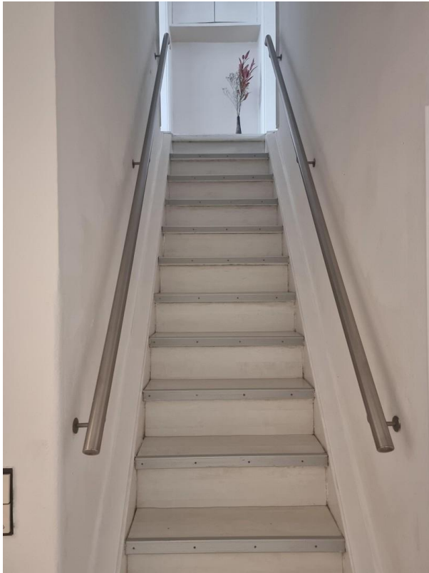
Treppe nach oben
