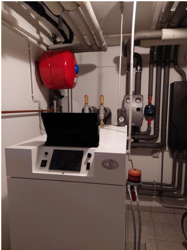
Öl-Brennwert Heizkesselanlage
