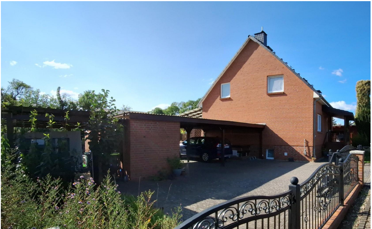
Haus 1 mit Carport
