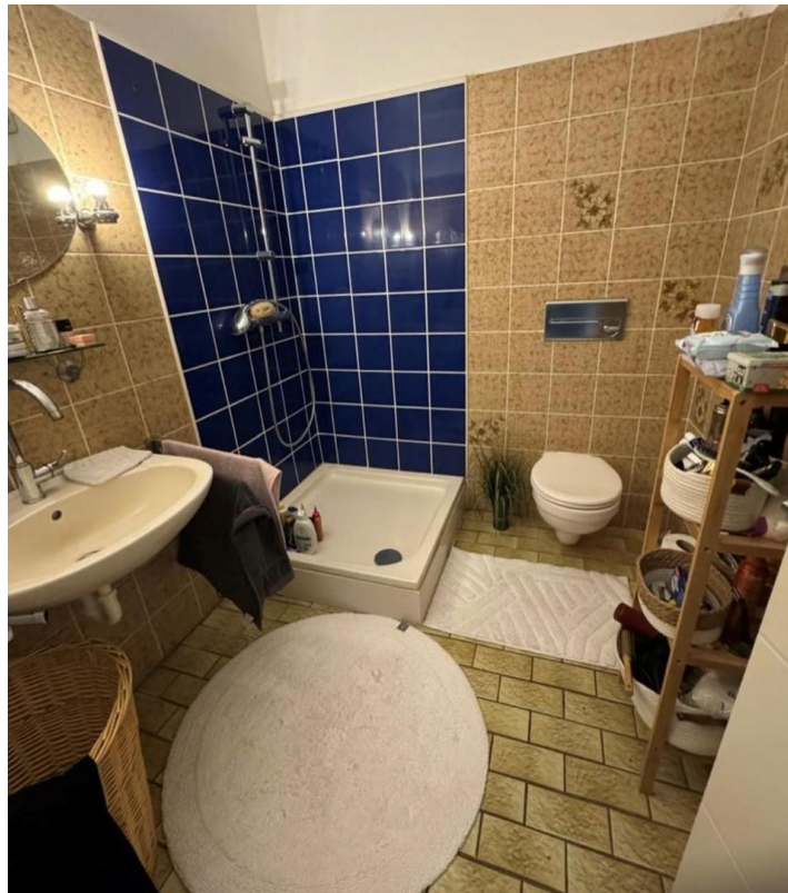
Bad (vor Sanierung)
