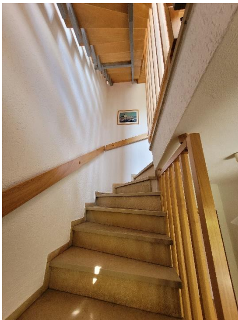
Treppe ins OG
