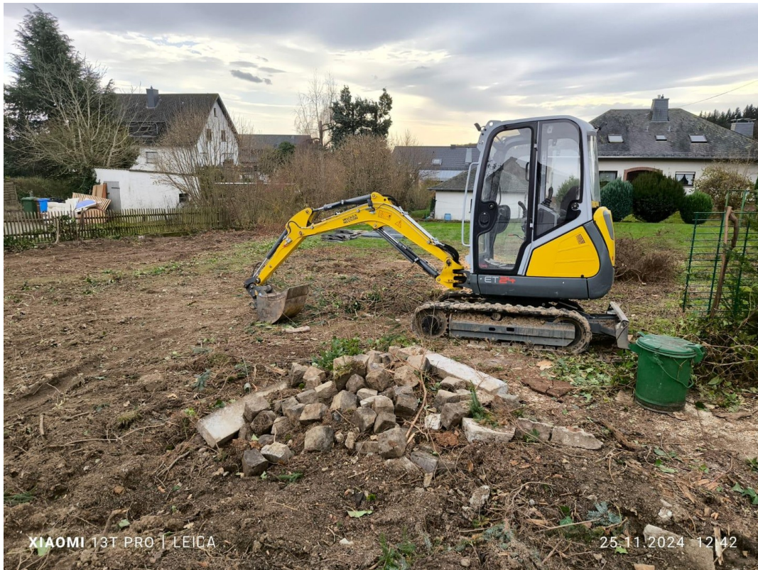
Beginn der Erdarbeiten
