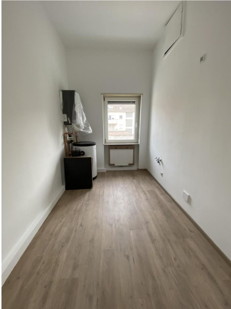
Küche mit Wärmepumpe
