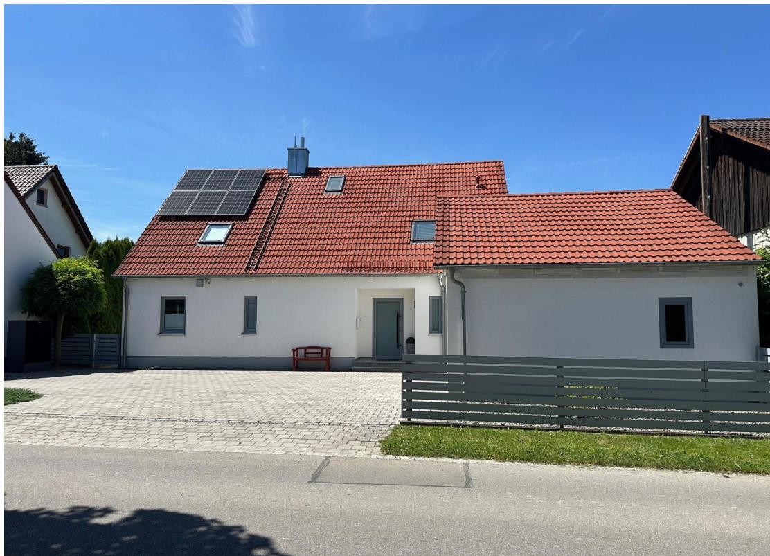
Ansicht Haus von Straße
