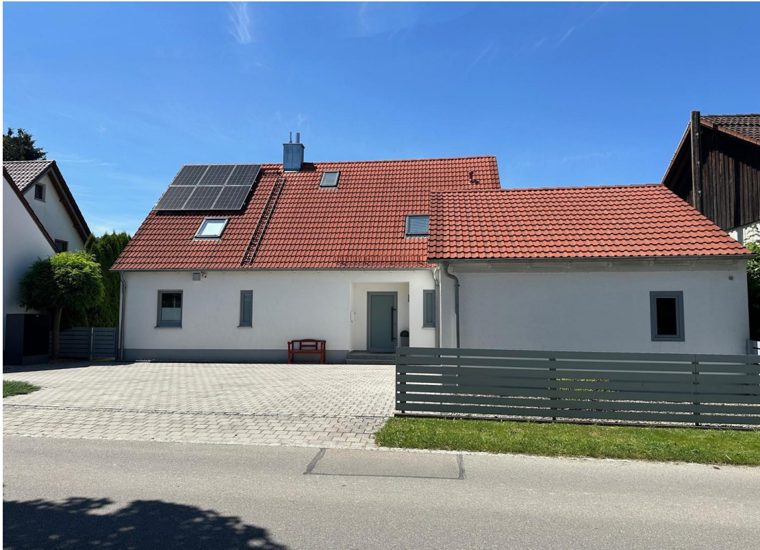
Ansicht Haus von Straße
