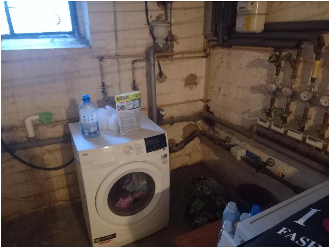
Kellerraum für Waschmaschine
