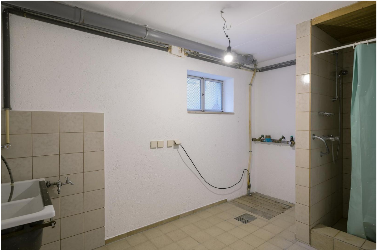
Waschküche mit Dusche Keller
