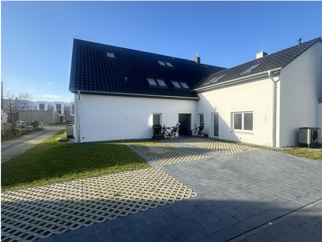
Eingangsbereich mit Parkplatz
