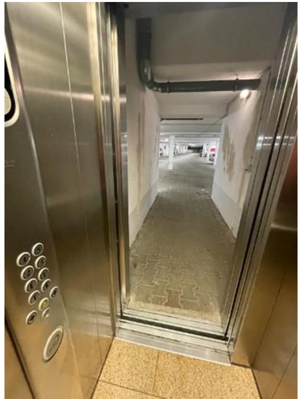
Aufzug zur Tiefgarage
