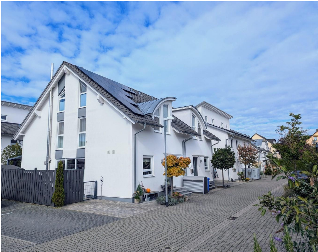
Blick auf die Südseite
