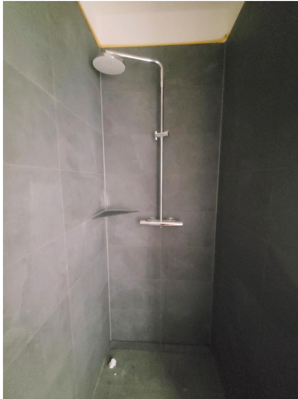
Bad 2 (noch im Bau)
