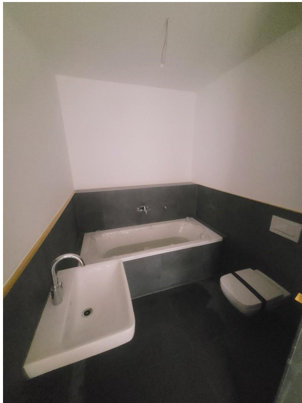
Bad 1 (noch im Bau)
