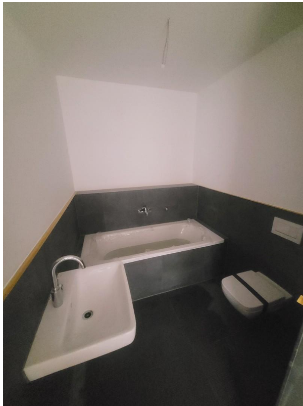
Bad 1 (noch im Bau)
