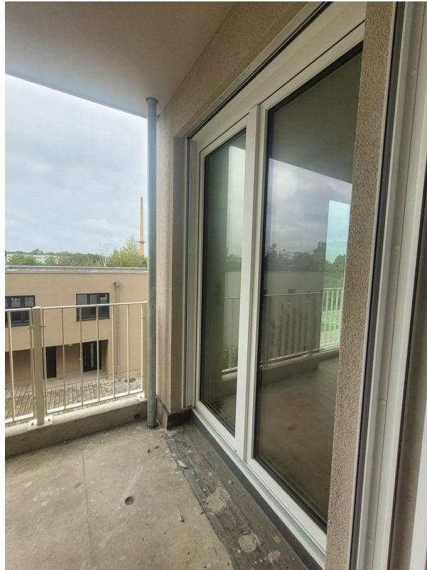
Zugang Balkon (noch im Bau)
