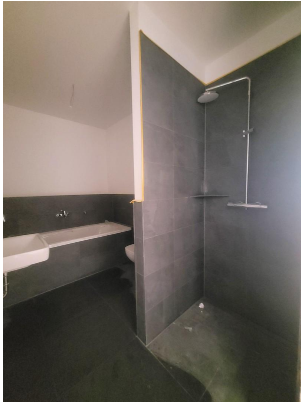
Bad 1 (noch im Bau)
