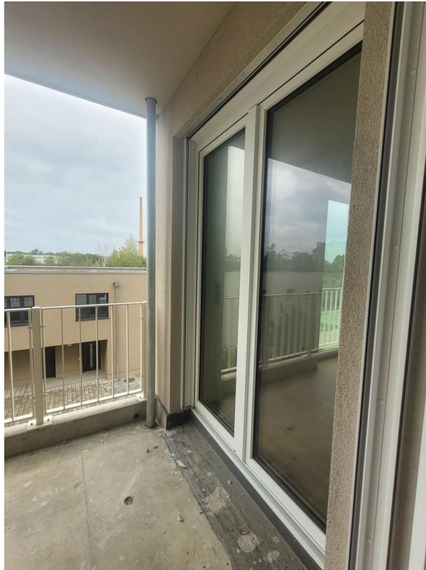
Zugang Balkon (noch im Bau)
