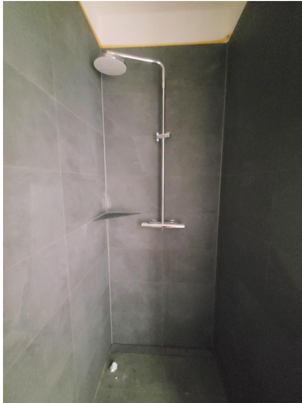
Bad 2 (noch im Bau)
